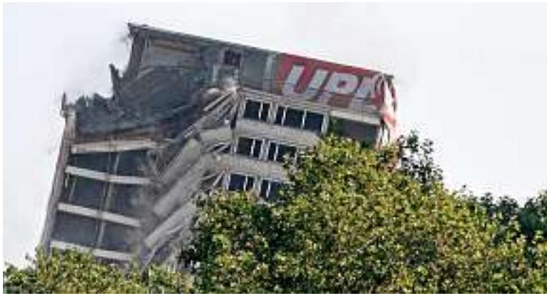
**Mit 750 Kilogramm Sprengstoff in 830 Bohrlöchern haben die Thüringer den 23-Geschosser in sich zusammenfallen lassen.**
